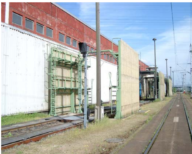
Bestehende Außenreinigungsanlage
