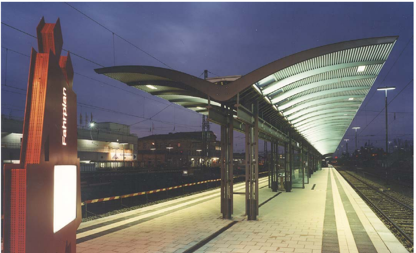
Inselbahnsteig mit Überdachung und Blindenleitsystem
