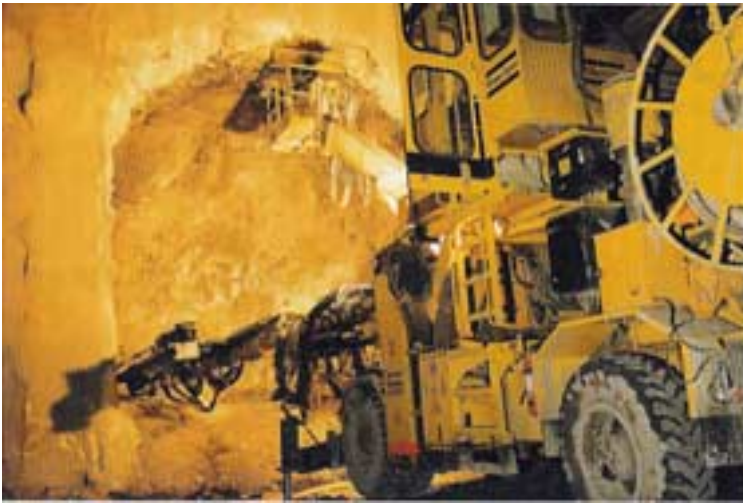
Im Sprengvortrieb-Verfahren sind Bohr-Jumbos im Einsatz.
