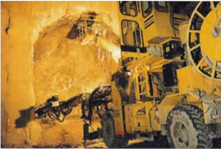
Im Sprengvortrieb-Verfahren sind Bohr-Jumbos im Einsatz.
