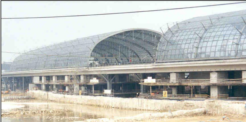
Bilder oben und rechts oben: Glasdach in Blickrichtung Ost
