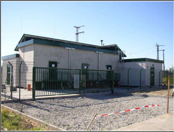
Gleichrichterunterwerk Flughafen Schönefeld
