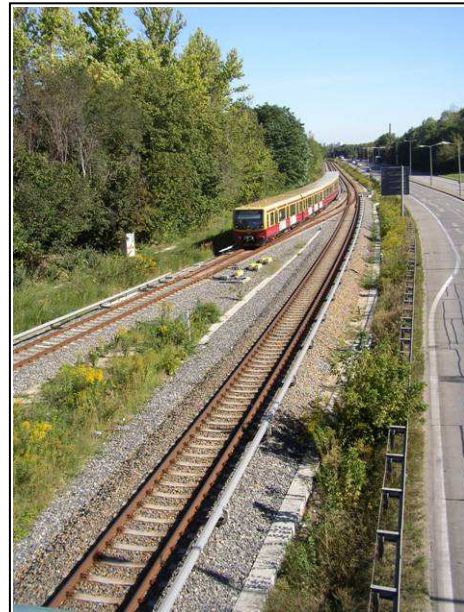
Grunderneuerung Oberbau zw. Grünauer Kreuz und Flughafen Schönefeld
