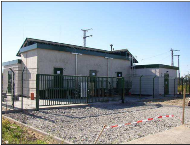
Gleichrichterunterwerk Flughafen Schönefeld
