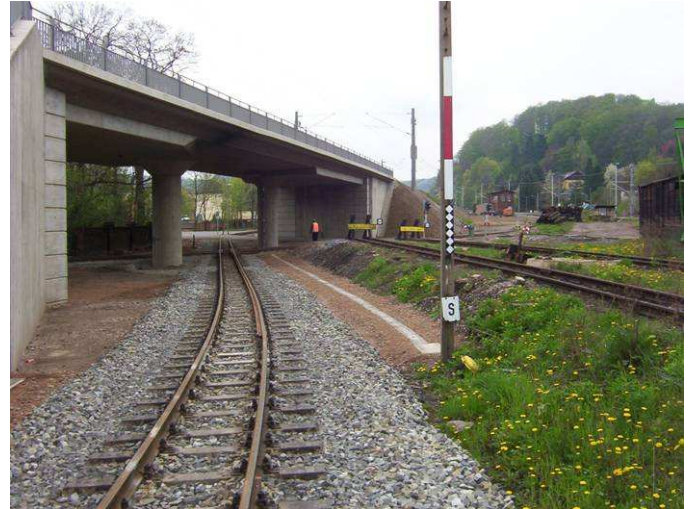
EÜ Pumphenbrücke-KRZBW mit Schmalspurbahn
