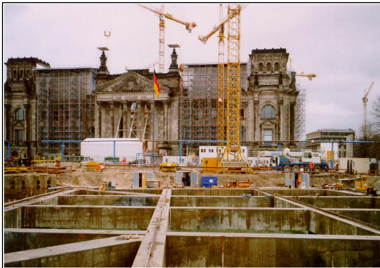
Platz der Republik, Baugrube Wand-Sohle Bauweise
