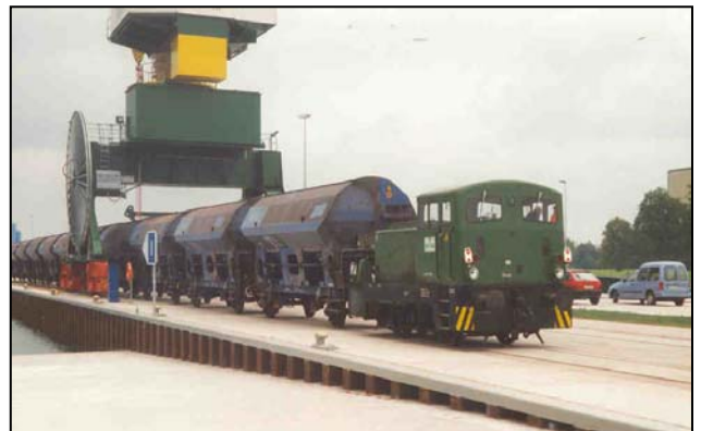
Vom Portalkran überfahrbare Gleise im Hafen Eberswalde
