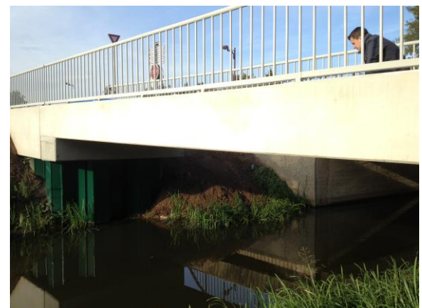
Ouvrage type dalle béton
