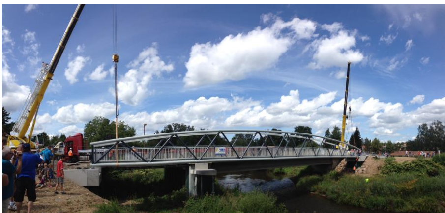
Pose de l'ouvrage en treillis aluminium
