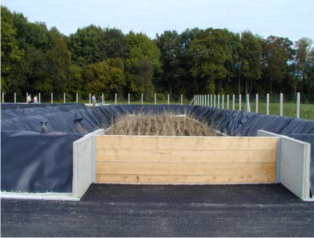
Vue sur un accès
