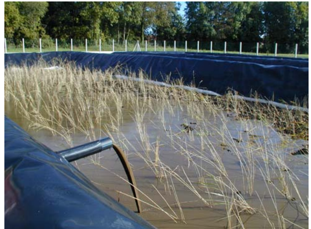
Mise en service de l'installation
