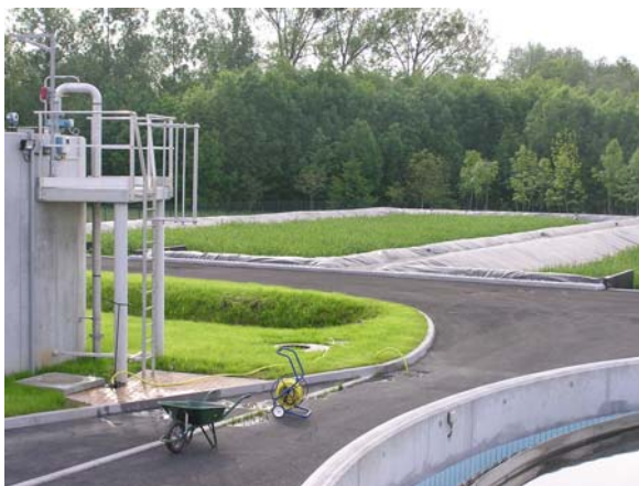
Vue vers les lits de traitement des boues
