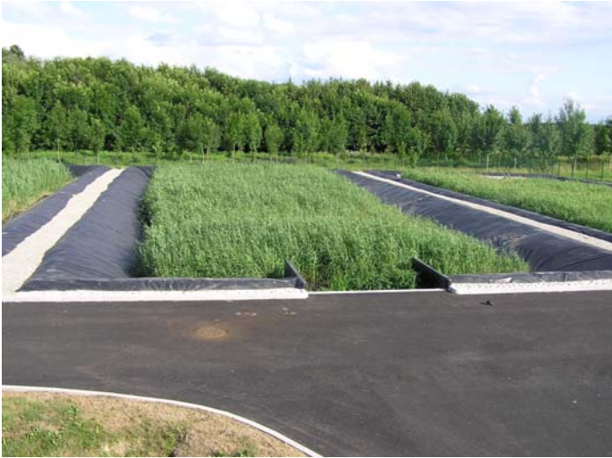
Vue d'ensemble de l'installation
